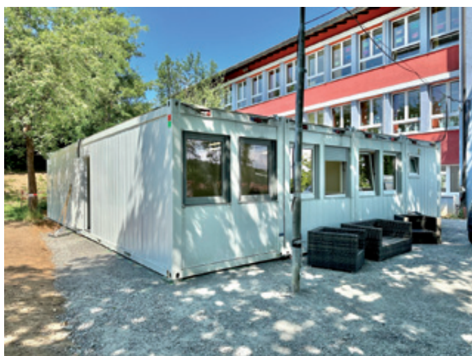
Container neben der Grundschule für unsere Schulkindbetreuung und das JUZ
